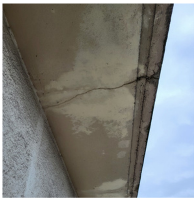
Fissure due à des infiltrations
